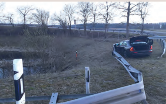
Die Leitplanke hält gerade noch Stand. So geriet der Fahrer bei einem Verkehrsunfall am 8.3.2024 nicht in das nahegelegene Regenrückhaltebecken.
